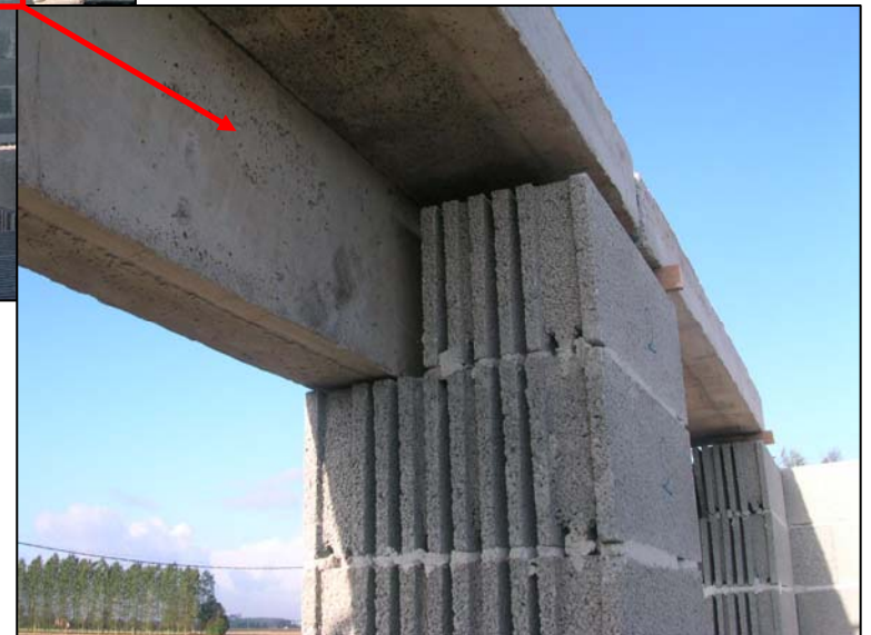
Linéau de coffre de volet roulant en pierre ponce vue de l'intérieure
